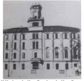
Edificio della Sede della Camera del Lavoro dopo l'incendio
